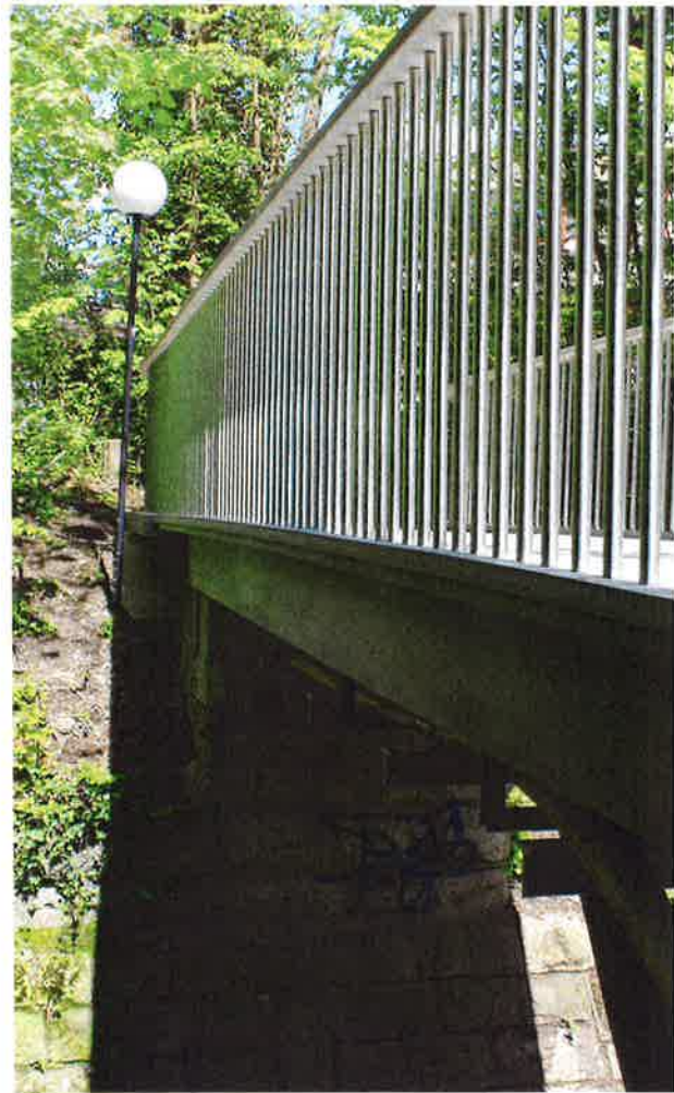
Seitenansicht der fertigen Brücke über der Eulach: Die Stahlhauptträger werden von allen Seiten abgeschirmt.
