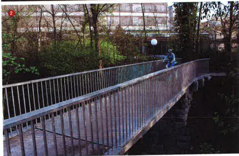
1 Eulachbrücke-Eckdetail mit Klebungen, Verschraubungen und gefrästen Wassernasen. 2 Fahrradbrücke über die Eulach zwischen ZHAW Campus T und Kantonsschule Bülrain in vorgespanntem Carbonbeton.
